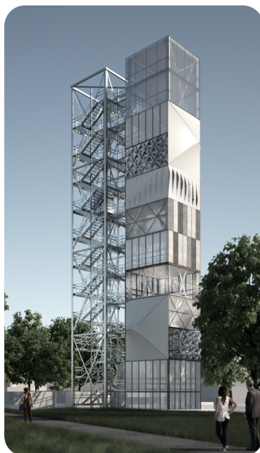
Abb. 2: Visualisierung des Demonstrator-Hochhauses mit diversen adaptiven Fassaden [2]
